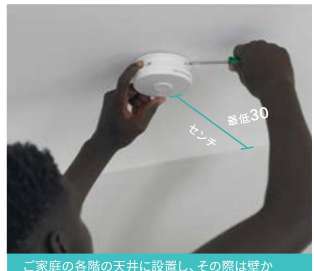
ご家庭の各階の天井に設置し、その際は壁から最低でも30センチの距離をおいて取付けてください。
